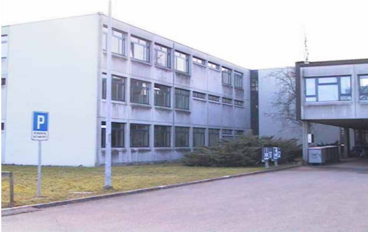
Unterkunft vom Kader und Zentrale Krankenabteilung
